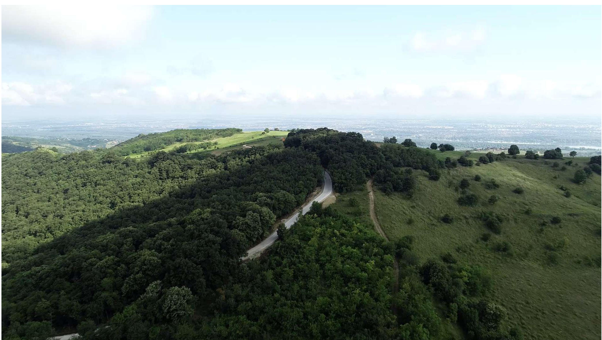
Izgradnja puta na lokalitetu Kesten
