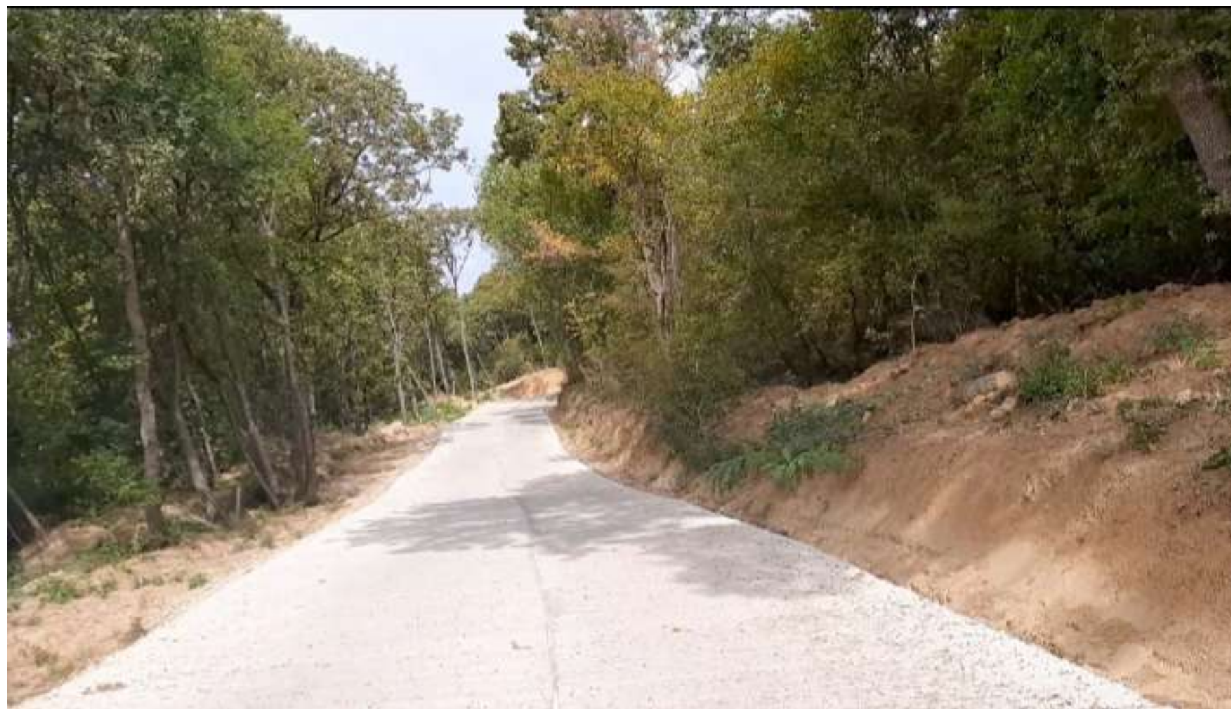
Betonski put na lokalitetu Kesten
